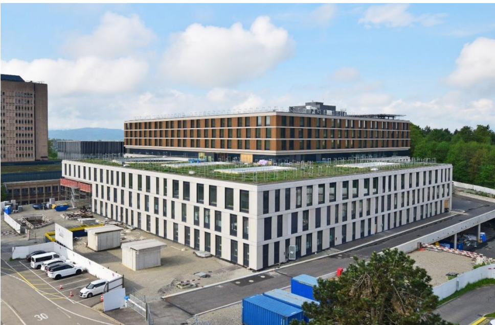
Blick auf den Neubau des Kantonsspitals Baden.
