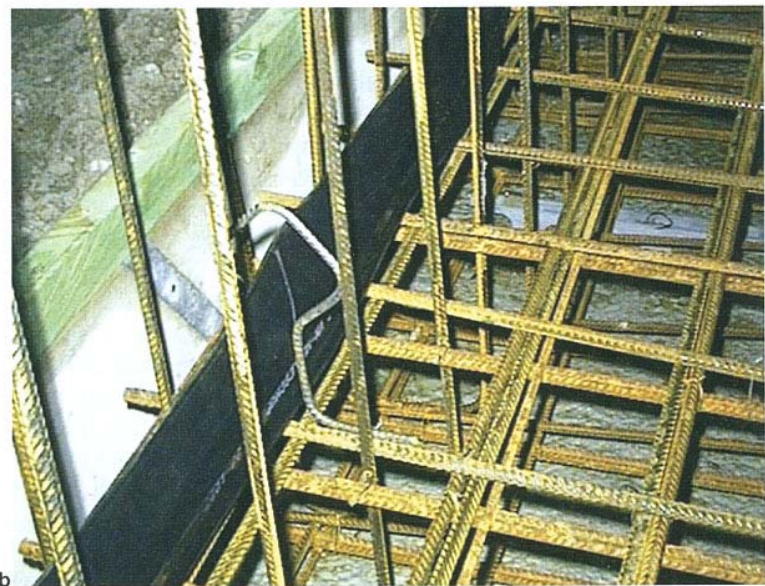
Bild 11. Kombi-Arbeitsfugenband KAB auf der obersten Sohlbewehrung vor dem Betonieren der Bodenplatte
