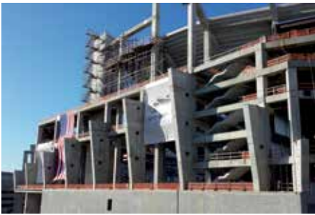
Eenvoudige aansluitconstructie van betonelementen
