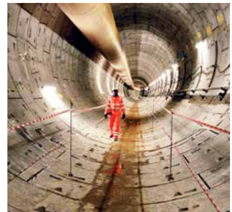
Bouw van een tunnel
