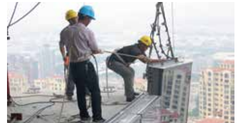
Een veilige en economische oplossing voor dynamische lasten bij de constructie van vliesgevels.
