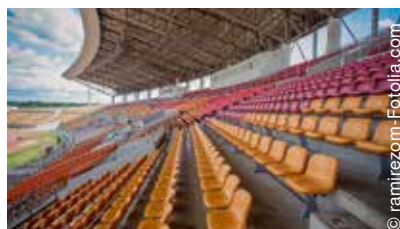
Elastyczny montaż krzesełek stadionowych.
