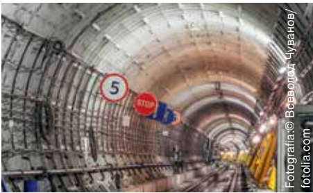
Mocowanie linii zasilania, znaków, systemów wentylacyjnych lub innych elementów w tunelach
