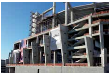
Prosta konstrukcja połączeń elementów betonowych.
