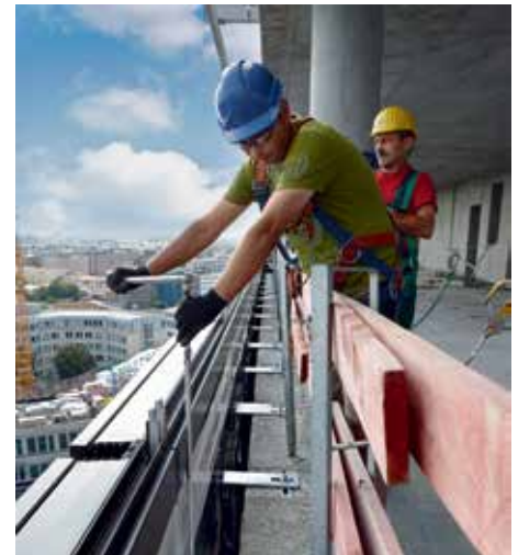
Szyny HAC-C-P są idealnym rozwiązaniem w przypadku ścian fasadowych kurtynowych
