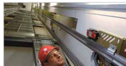
Développé et homologué pour les charges de fatigue, p. ex. montage d'ascenseurs.
