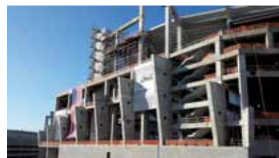
Construction adjacente simple d'éléments en béton.
