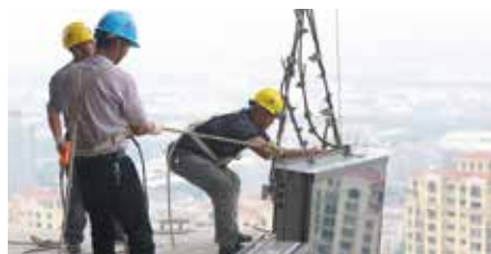
Une solution sûre et bon marché pour les charges de fatigue lors de la fixation des murs-rideaux.
