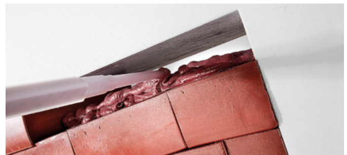
Kombination von Brandschutzsteinen mit Brandschutzschaum.
