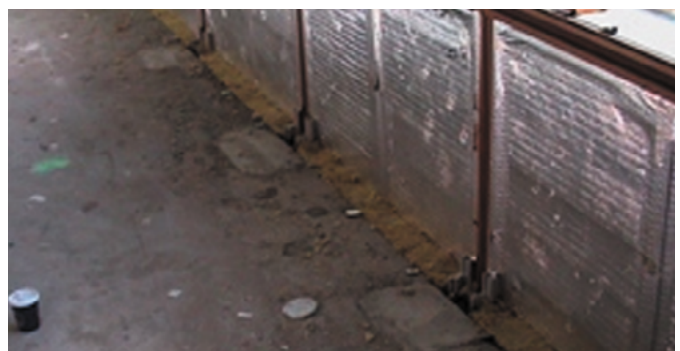
Mit Mineralwolle geschlossener Spalt.
