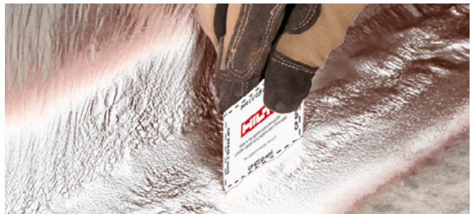
Überprüfung der Dicke des Nassfilms.
