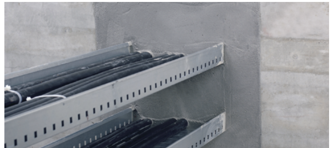
Abschottung sehr großer Durchführungen mit Brandschuttmörtel CP 636.
