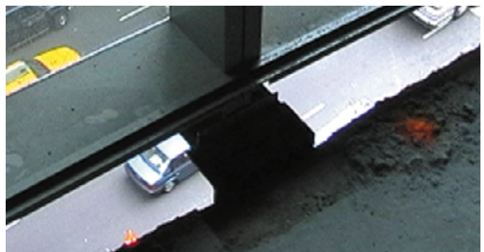
Offener Spalt zwischen Fassadenelement und Decke.
