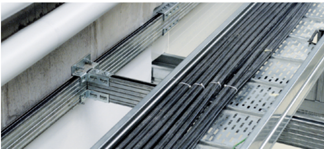
Verlegung von Kabeln.
