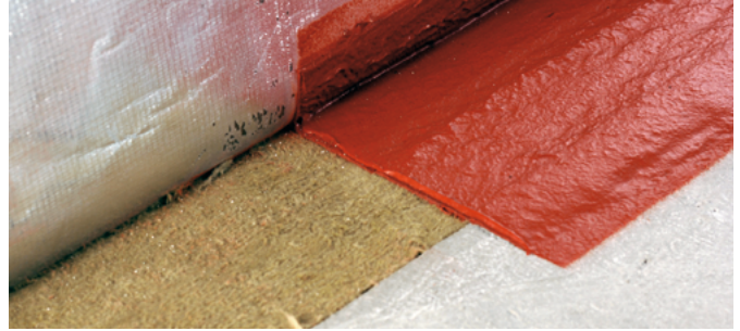
① Fuge Außenwand (Fassade) zum Boden.
