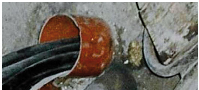
Hüllrohr bündig mit Wand/Decke abschneiden.
