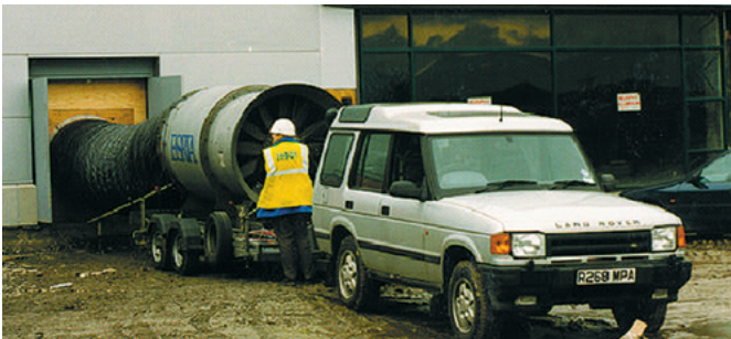
„Blower door test“
