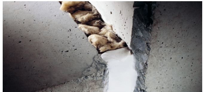
Brandschutzdichtmasse CFS-S SIL/CFS-S ACR.
